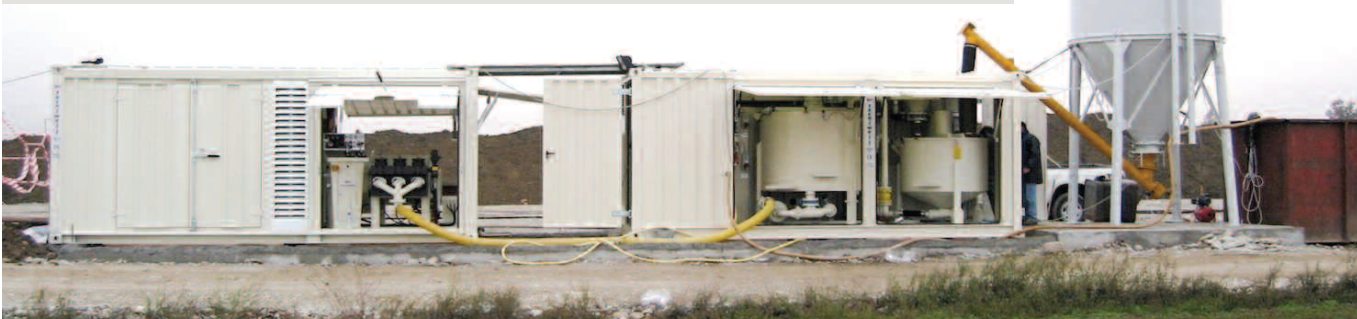
Attrezzature posizionate in cantiere Job-site view
