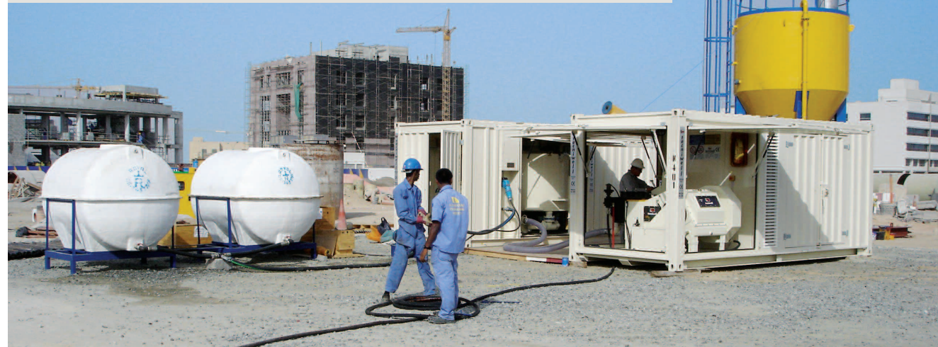
Attrezzature posizionate in cantiere Job-site view
